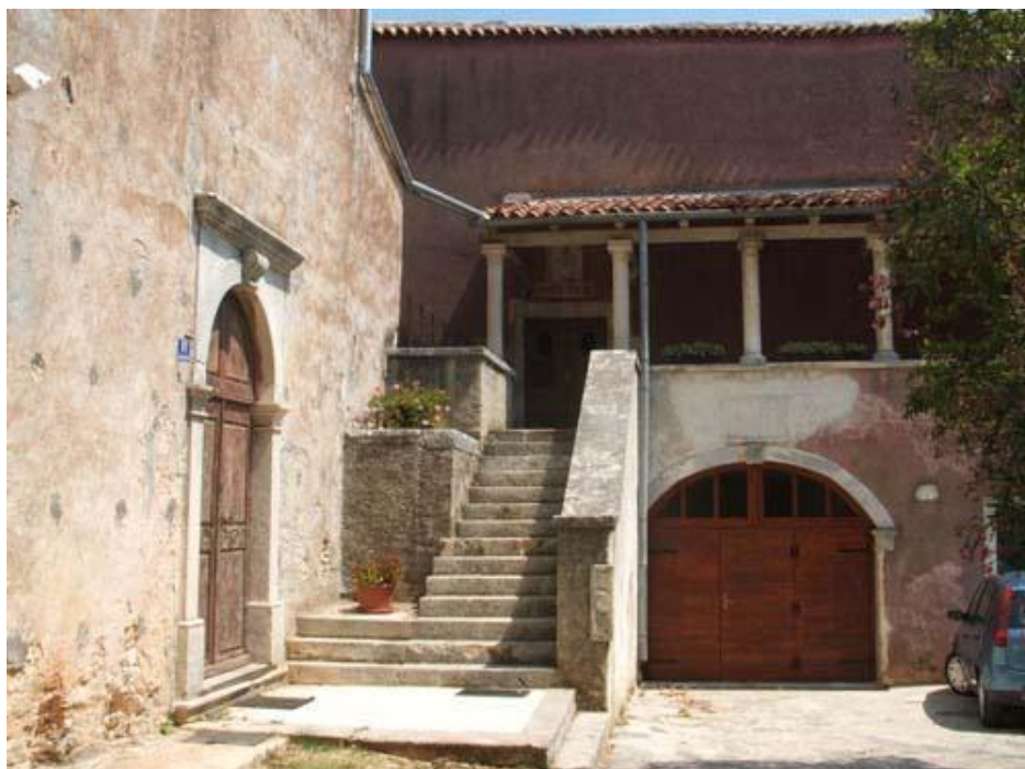
Bočni ulaz u crkvu i stepenište prema loži na stupovima palače Loredan
